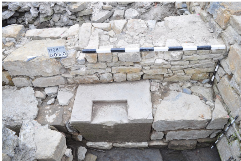
Fundament der Herrenmühle (Ausschnitt) mit dem Auflager für die Achse eines Mühlrads
